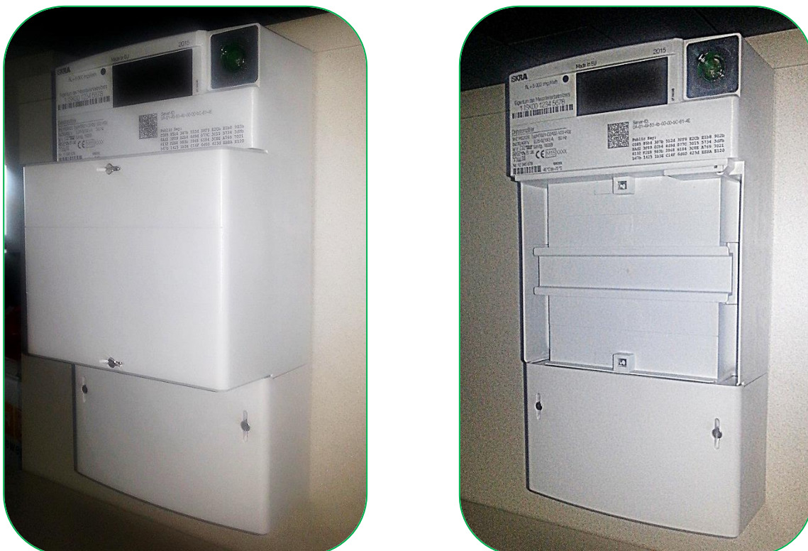
Bild 42: Moduldeckel abnehmen
